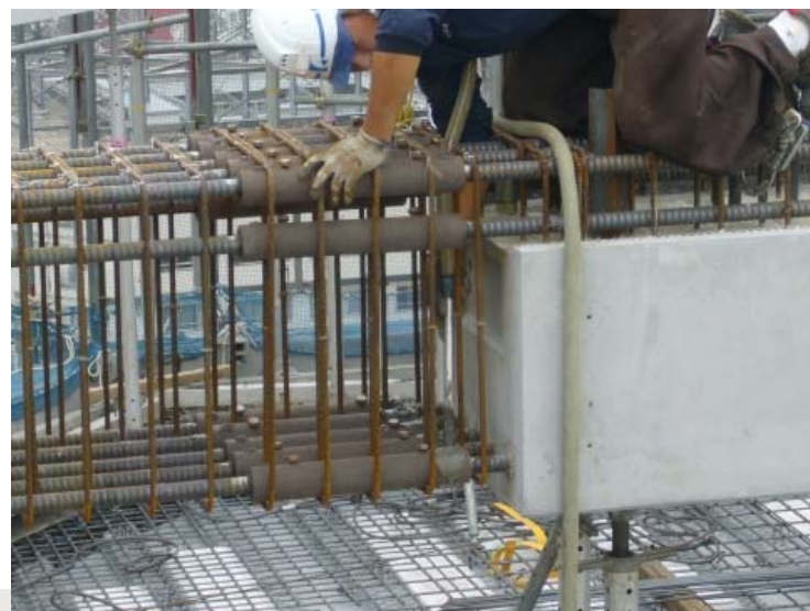
④砂漿注入充填
