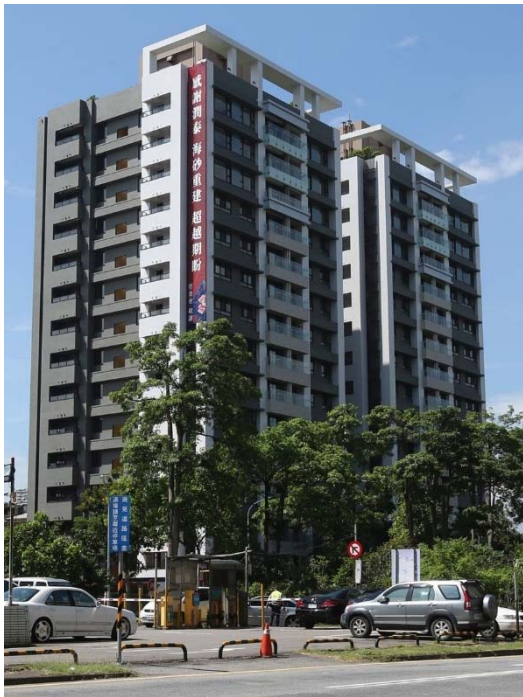
海砂屋拆除重建 潤泰(新)雙子星15層樓
